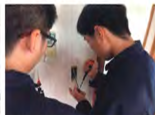
修理修繕②
