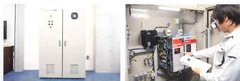
DIC'SE自社設計のモータドライブ装置制御盤とその内部
