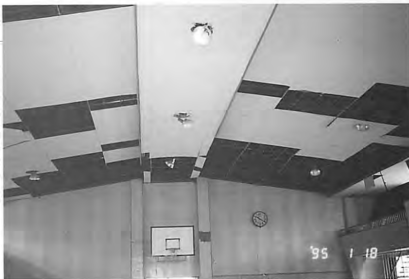
落下した体育館の天井板（神戸市立丸山中学校）
