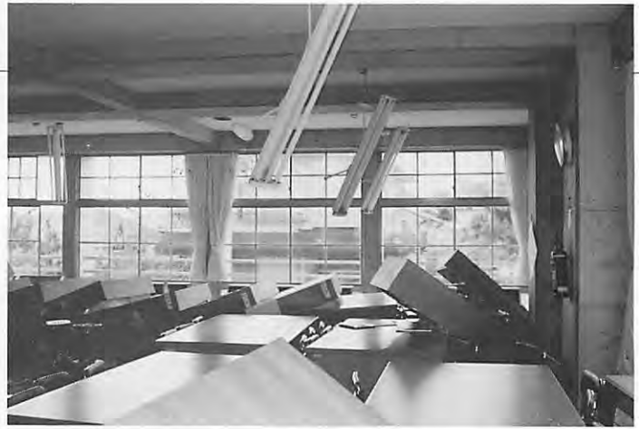
書架が倒れ、蛍光灯が今にも落ち そうな図書室（芦屋市立朝日ヶ丘 小学校）
