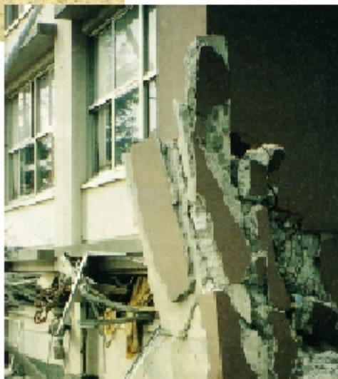
1階部分が破壊した校舎
