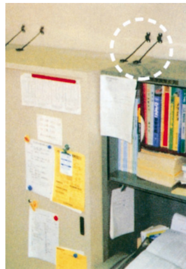
ロッカーの内容物の重量が 200kg 以下のときは、16 番線の針金 2 本とＬ字金具で固定してもよい。
