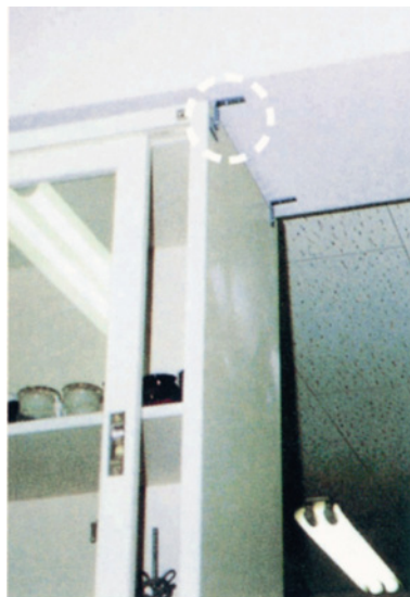
Ｌ字金具とアンカーボルトで天井に固定する。
