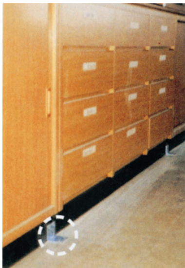
Ｌ字金具とアンカーボルトで床に固定する。
