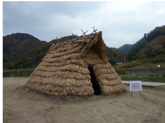
完成した鍛冶工房建物
