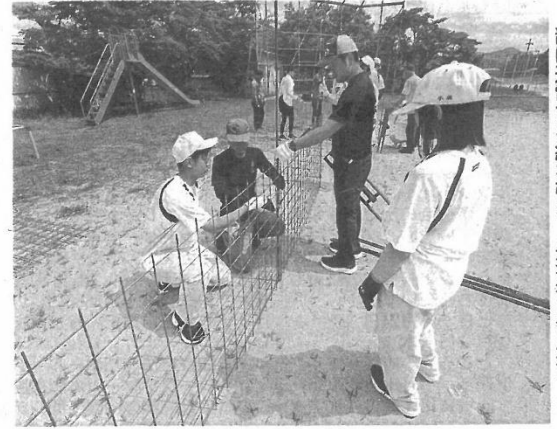
グラウンドで獣害対策の柵の設置を体験する高校生ら。柵の下部はワイヤメッシュ、上部に通電する線を張る。丹波篠山市畑宮
