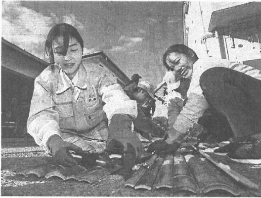
短冊状に割ったモウソウチクをシュロ縄で編んで床を作る高校生と大学生
