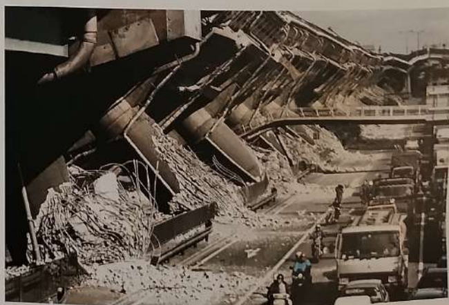
阪神・淡路大震災の被災状況 【内閣府防災情報のページより】
