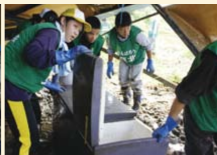
泥かきやがれき撤去作業 (写真提供 神戸新聞社)
