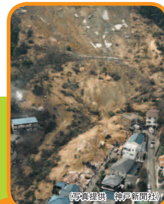
↓ 地すべり (西宮市仁川百合野町)
