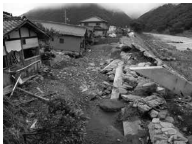
崩壊した佐用川の護岸
