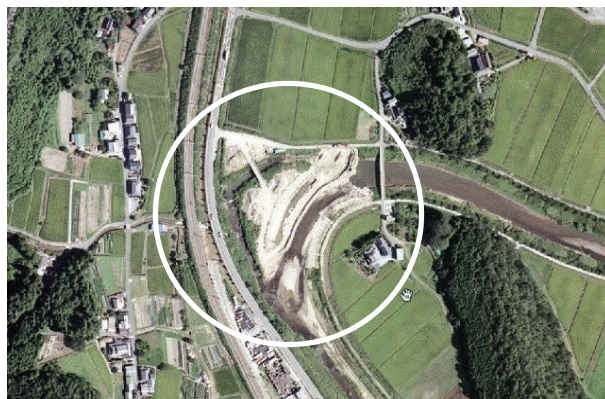
▲ 武庫川日出坂洗堰護岸工事の様子(平成17年)
