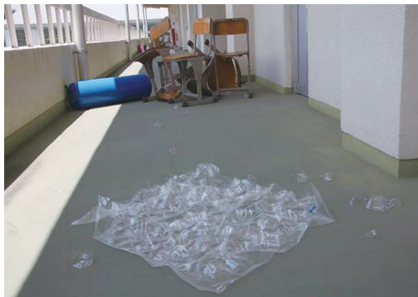
▲ 障害物やガラス片が散乱
