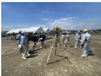
施工現場見学
