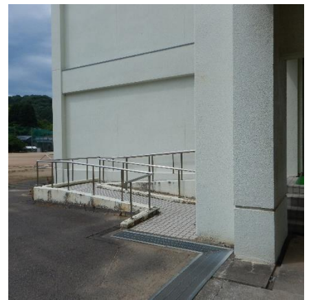
③ 本館(特別教室棟2側)入口
