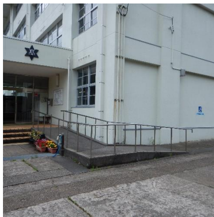
② 本館(国道側)入口
