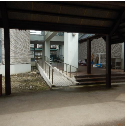
⑦ 漁業水産実習棟入口
