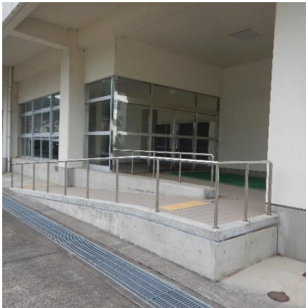
① 体育館入口
