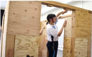
耐震個室組み立て
