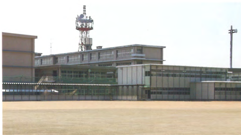
仮設校舎（第2期耐震工事 2012年）
