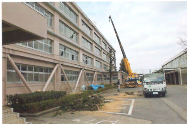
ヒマラヤスギの伐採工事（2012年）
