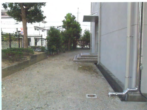
清流館玄関（工事前 2013年）
