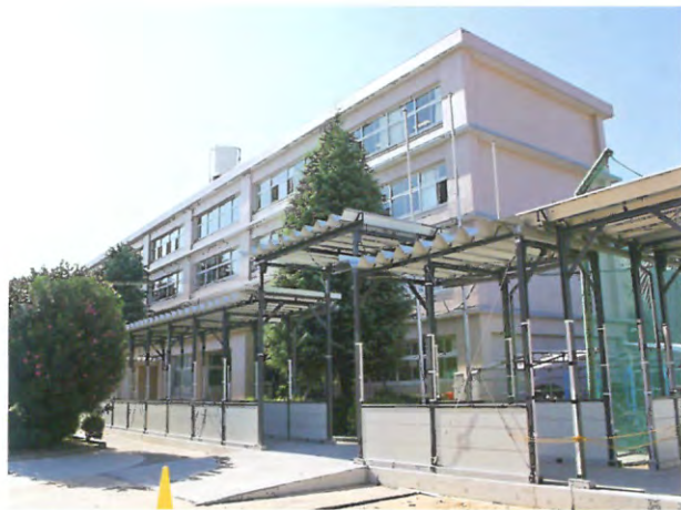
仮設校舎への渡り廊下
