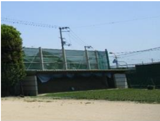
防球ネットの増設以前の状態
