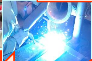
フレームの溶接
