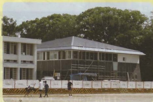
(建設中の百周年記念館)
