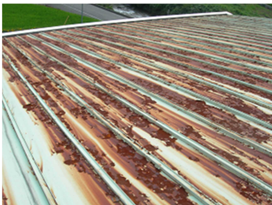
■ 体育館屋根の防水劣化
