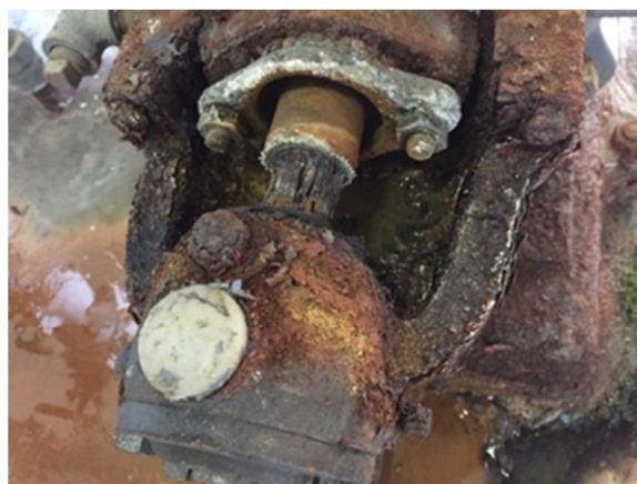
■ 揚水ポンプの腐食・破損
