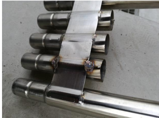
② 溶接して修理
