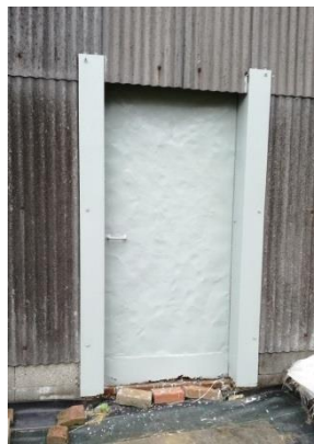
④ 新調して設置した扉(内側、取手と鍵)
