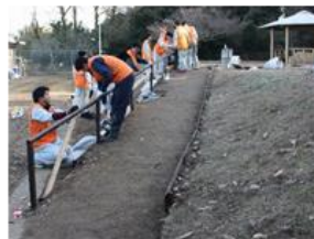
仮設住宅から公園へのスロープ整備 階段の予定が急造スロープに変更依頼。 切土・盛土が同じになるように斜面を設 定。カッコイイ手すりもつけました。
