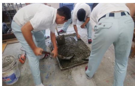
▲手練りコンクリート打設
