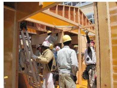
(d) 3年生 木造仮設住宅組立て
