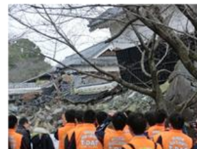
熊本城修復現場見学 至る所で石垣が崩れ、建物が傾いていま した。熊本城の完全修復には20年を要す とのことでした。
