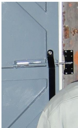
④ 新調して設置した扉(内側、取手と鍵)
