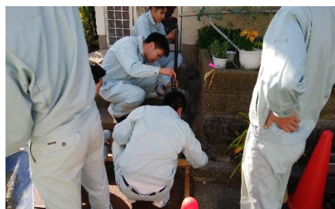
▲ 掘削後基礎モルタル (□300×300 H=300mm) を流し込み
