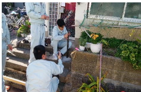
▲ 掘削後基礎モルタル (□300×300 H=300mm) を流し込み
