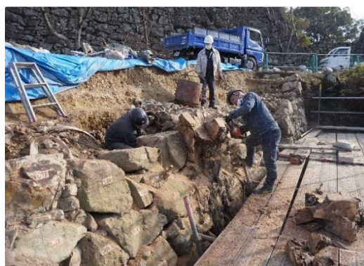
[石垣修繕作業]
