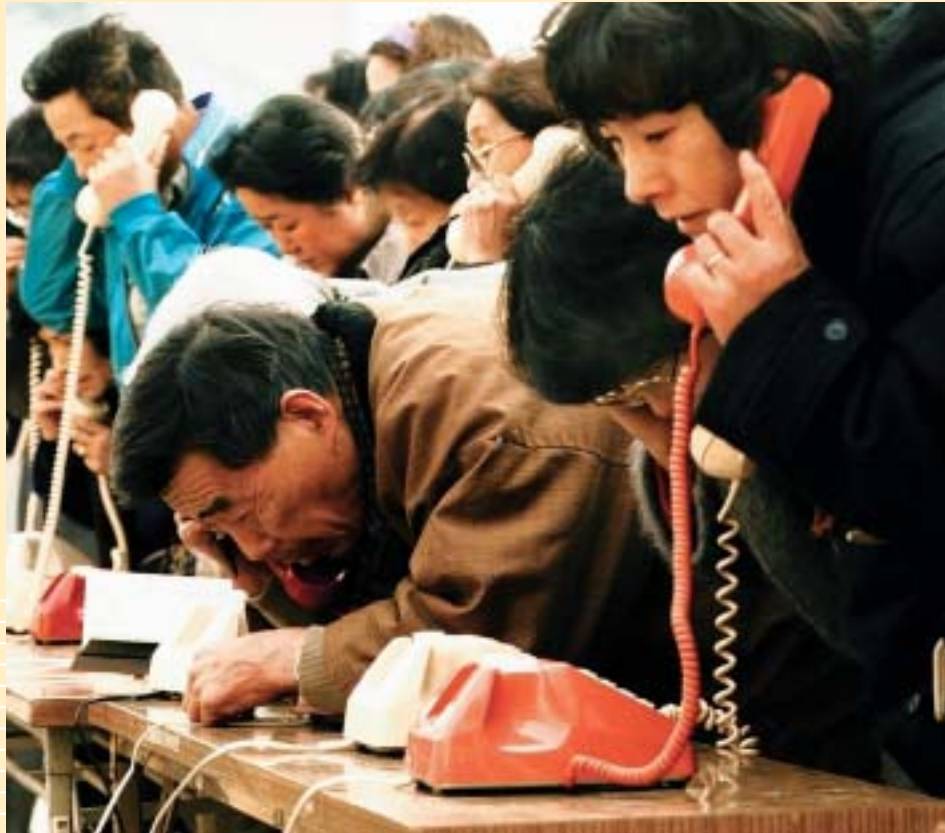
通信機能がマヒ、小学校に設置された仮設電話で、必死に連絡しようとする被災者 (95年1月18日、神戸市長田区、神戸市立蓮池小学校)
