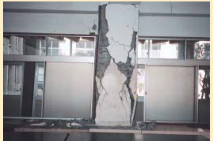
西宮市立上ヶ原中学校校舎支柱に亀裂(1階)
