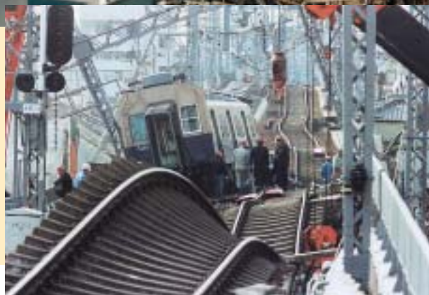
曲がりくねった線路、急ピッチで 復旧が進む阪神電車(95年1月21日)
