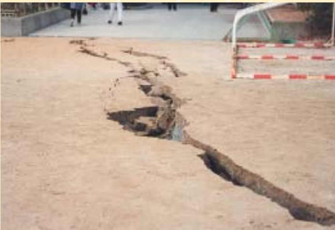
グラウンドに亀裂が生じた芦屋市立打出浜小学校
