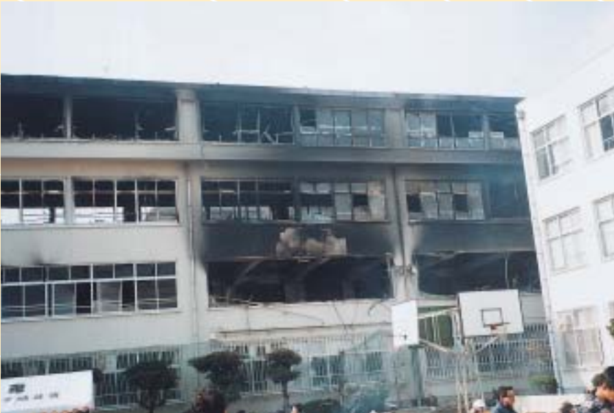
校舎の2階以上が焼失した神戸市立烏帽子中学校
