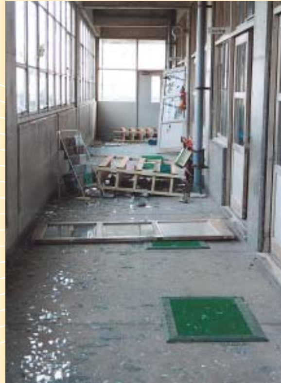
芦屋市立朝日ヶ丘小学校2階廊下
