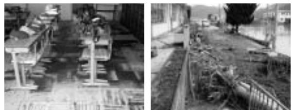
豊岡市立新田小学校 床上浸水した1階教室と玄関前
