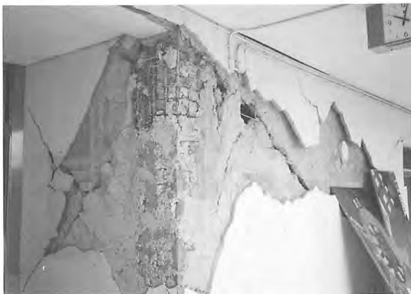
校舎は、大きな被害を受けた。写真は、支柱のコンクリートが剥離した給食室付近(西宮市立上ヶ原中学校)
