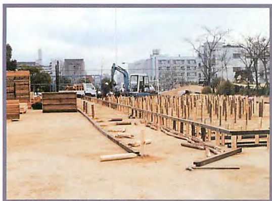
仮設校舎の建設もどんどん進んだ (神戸市立福池小学校)
