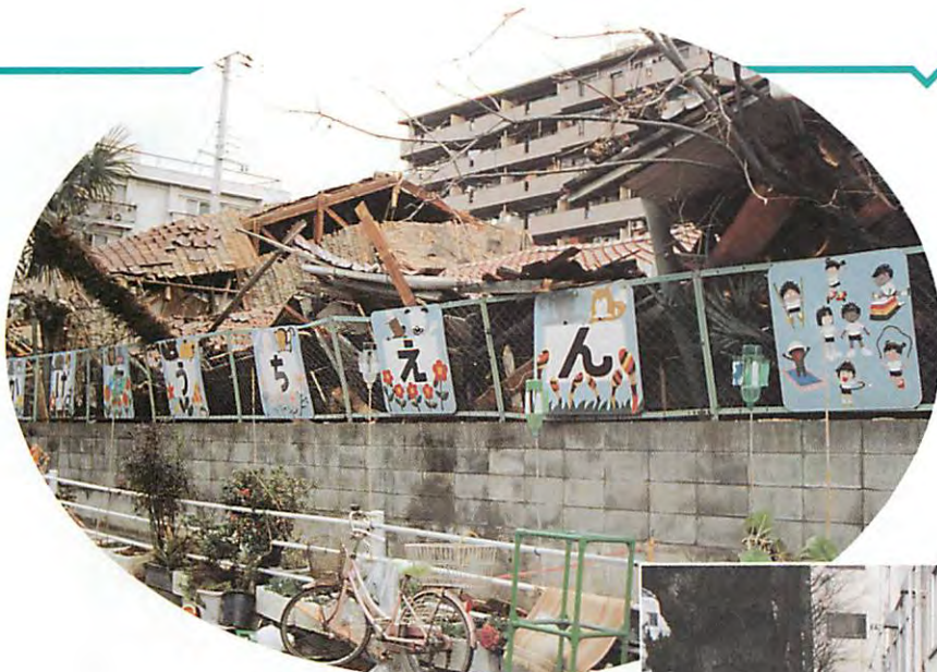
倒壊した木造圍舎（神戸市立御影幼稚園）
