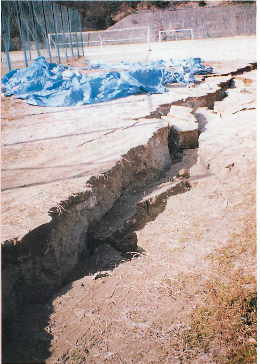
運動場に生じた亀裂 (県立宝塚西高等学校)
