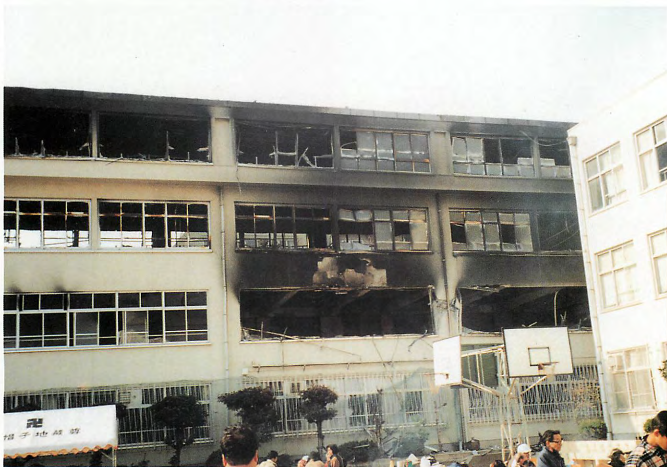
神戸市立烏帽子中学校では、地震直後に火災が発生し、校舎の2階以上が焼失した
