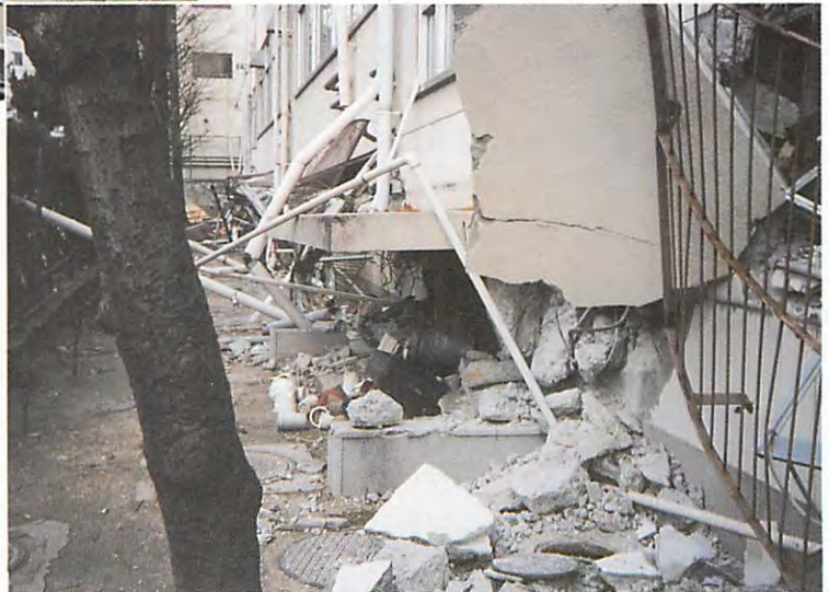
校舎の1階部分（神戸市立御影中学校）
