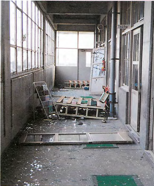
割れたガラスが飛び散った校舎内部 (芦屋市立朝日が丘小学校 2階廊下)
