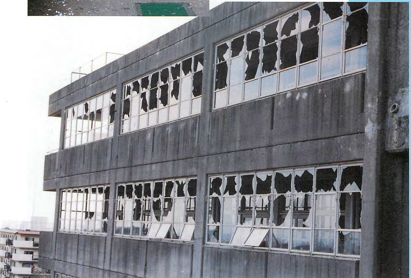
固定された窓ガラスは地震の衝撃で割れてしまった (芦屋市立朝日が丘小学校)
