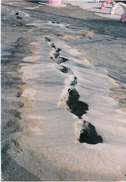
液状化現象で土砂が吹き上げた園庭 (芦屋市立浜風幼稚園)
