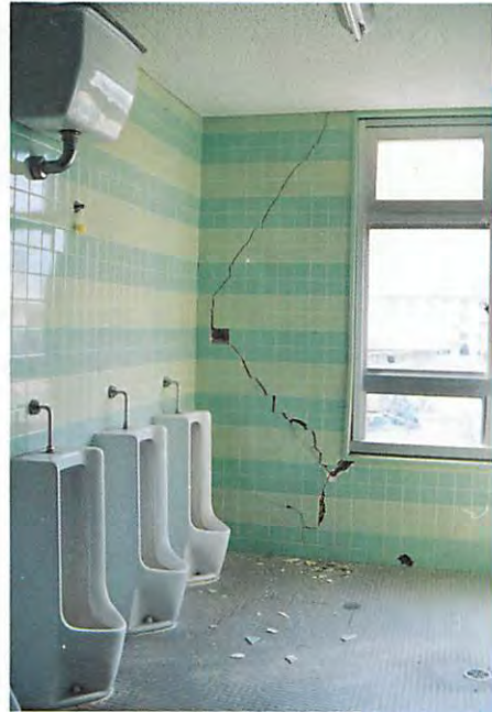
破損したトイレ (明石市立花園小学校)
