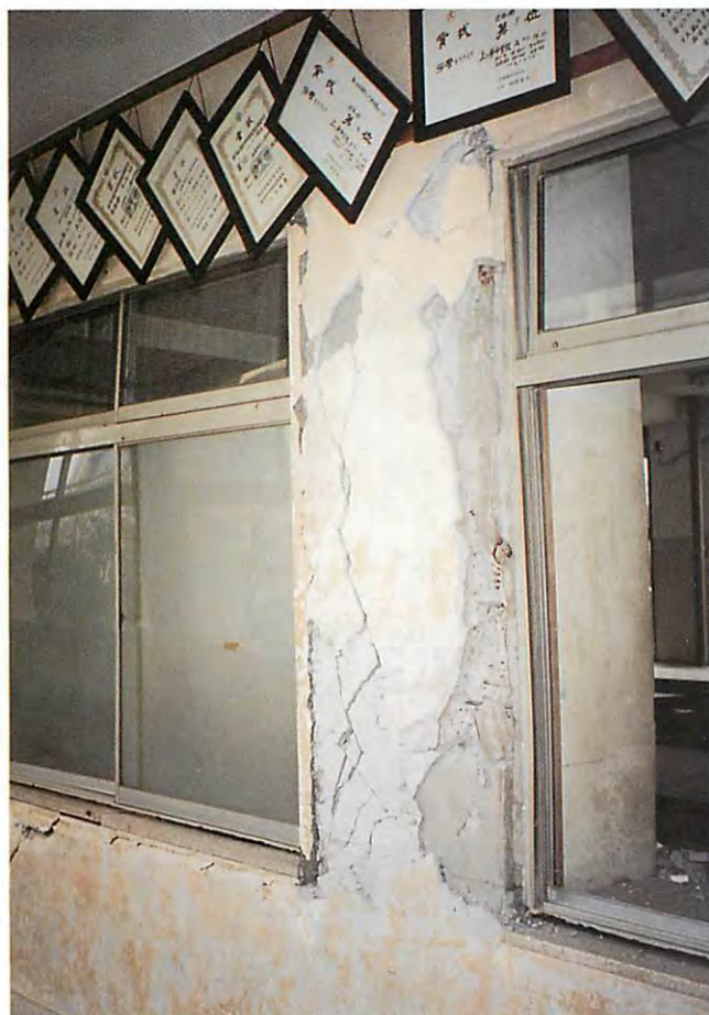
鉄筋コンクリート製の校舎の柱も地震のすさまじい力でねじ曲ってしまった （西宮市立上ヶ原中学校）
