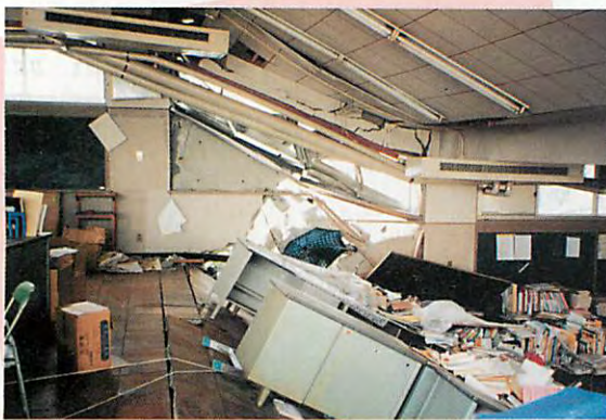
職員室の内部 （西宮市立西宮高等学校）
