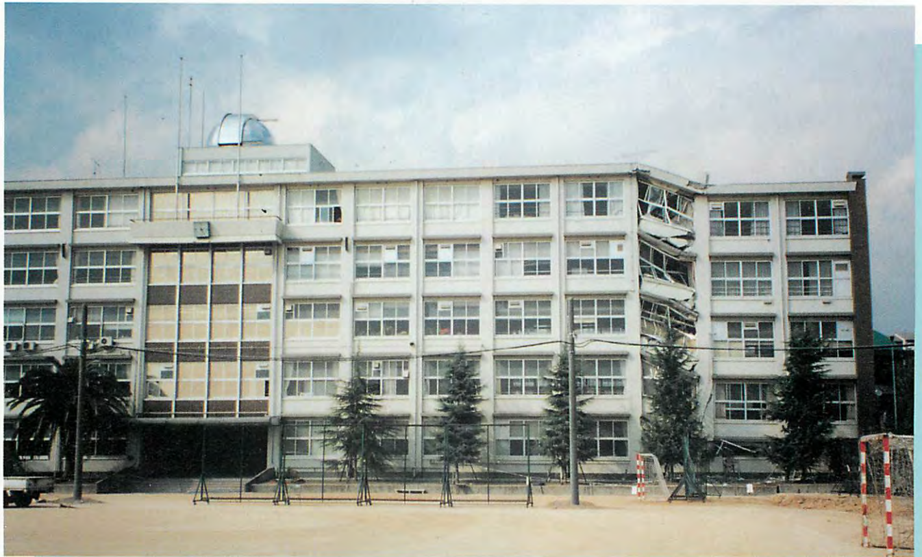
段違いになってしまった校舎（西宮市立西宮高等学校）
