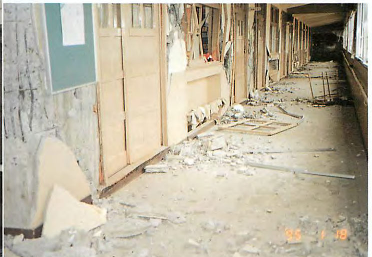
破壊された廊下（神戸市立丸山中学校）
