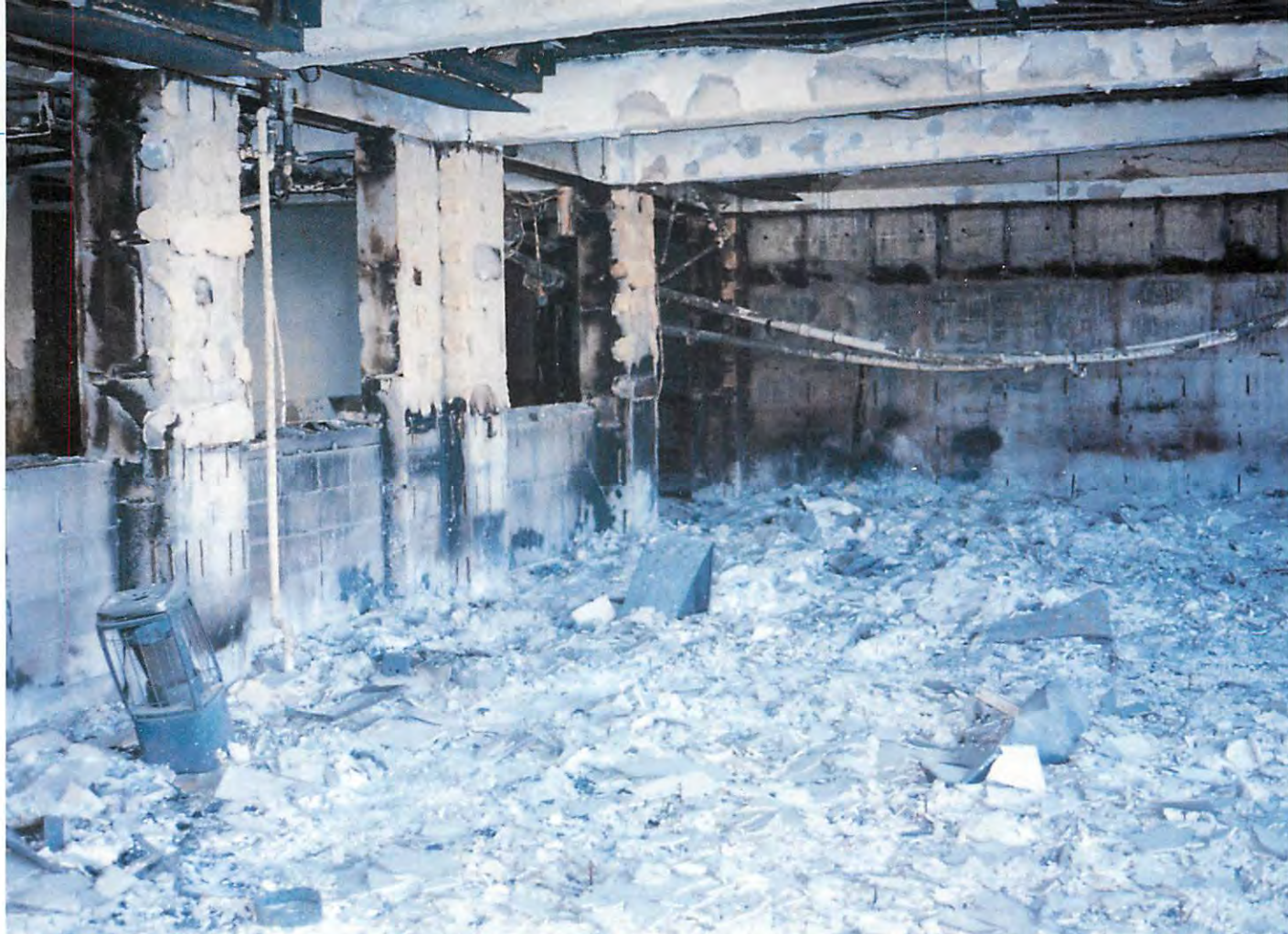
地震による火災で全焼した教室棟（神戸市立烏帽子中学校）
