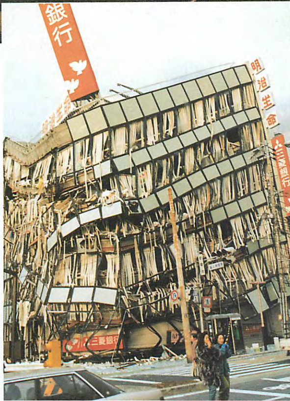
すさまじい揺れは、鉄筋コンクリートのビルをも崩壊させた（神戸市兵庫区）
