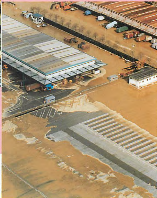
埋め立て地では、液状化現象のため、泥が地中から噴き上げた（神戸市ポートアイランド）
