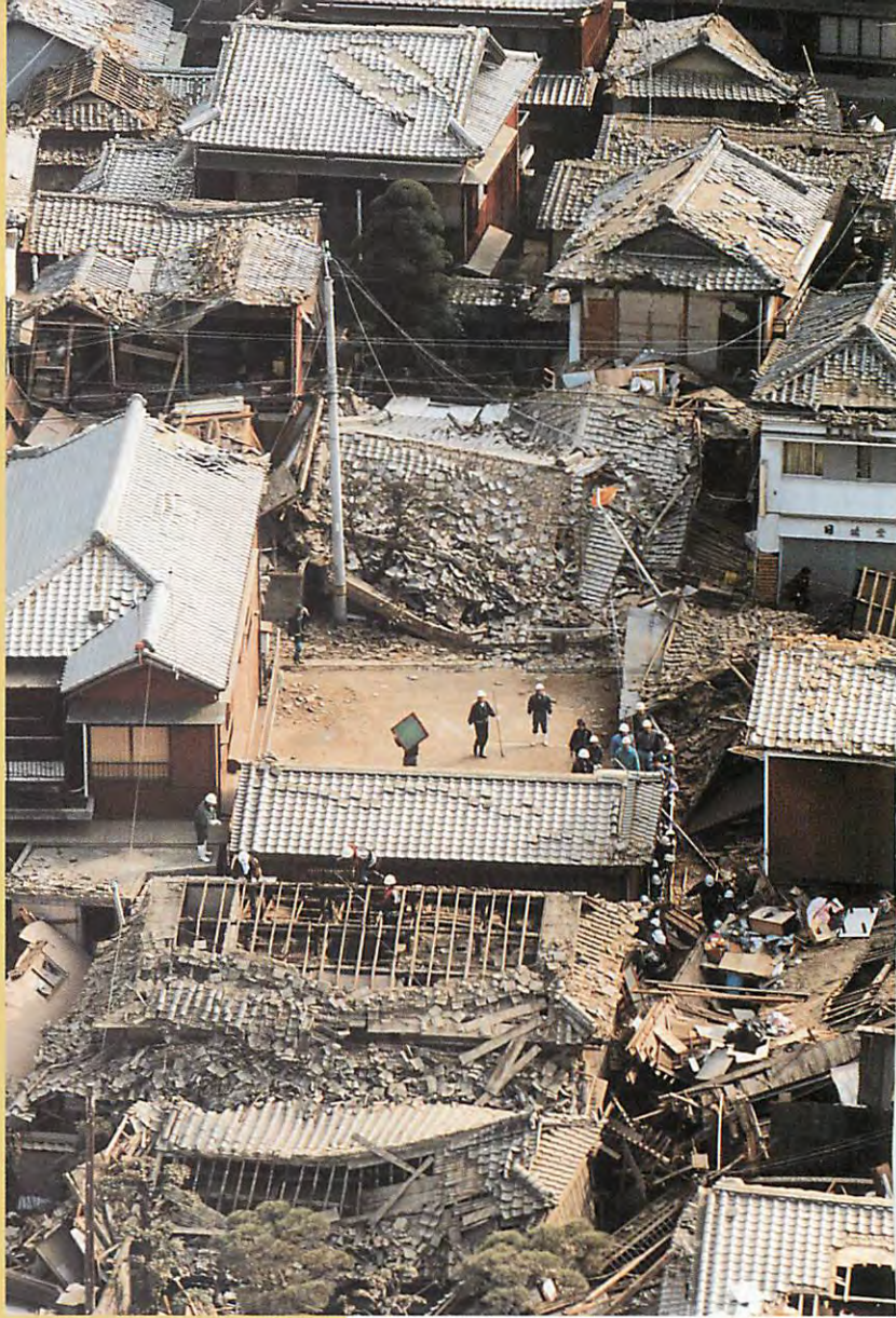
屋根瓦が粉々に砕け、木造家屋は軒並み倒壊 (津名郡北淡町)
