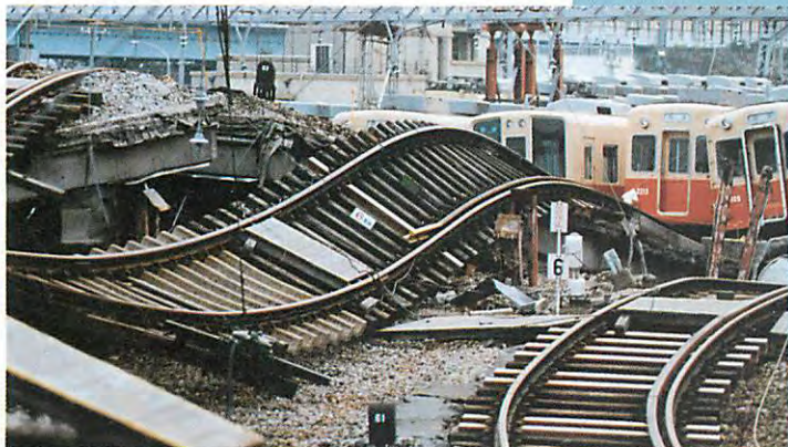
鉄道も大きな被害を受け、交通網は壊滅的なダメージを受けた (阪神電車石屋川車庫)
