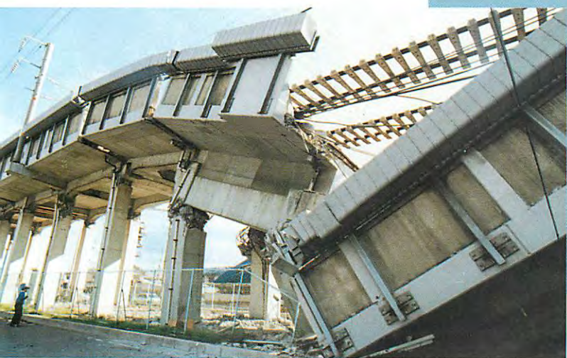
新幹線の高架も橋桁が大きく傾き、倒壊した (西宮市)
