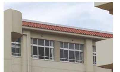
屋根瓦の上にあるソーラーパネル (神戸市立本庄小学校)
