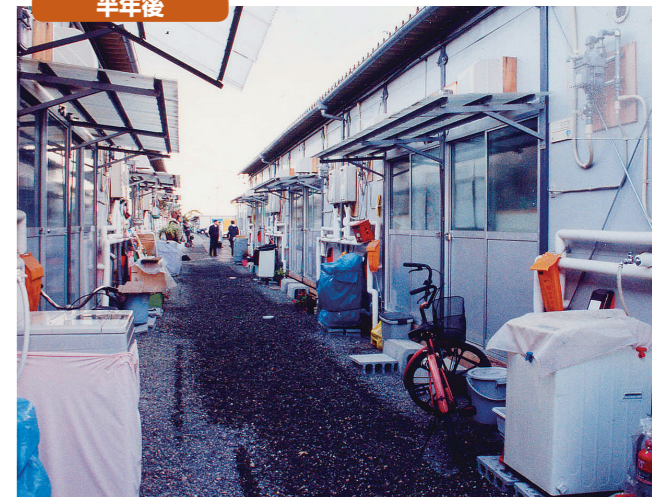
(写真提供 人と防災未来センター)
