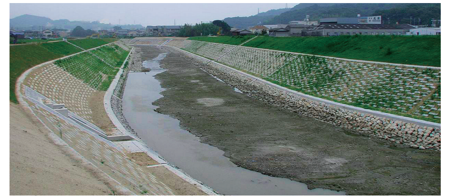
平成16年、台風23号による大雨で被災した洲本川の改修工事(洲本市)
