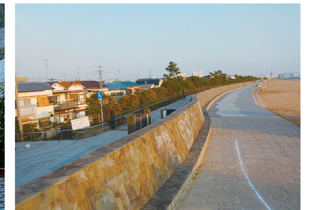
高潮を防ぐ防潮堤(西宮市)
