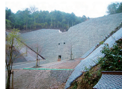
土石流を防ぐ砂防えん堤(篠山市)
