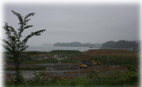
かつて町があった所(盛土の様子)
