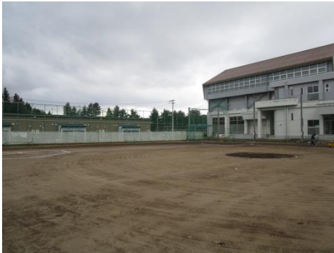
グラウンド横には2年前と変わらず、仮設住宅がありました。
