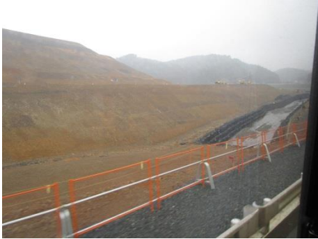
町の中は高い土の山ばかりでした。昔の道路が埋まっています。
