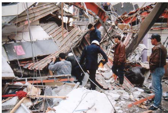
阪神・淡路大震災で倒壊した家屋
