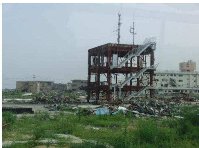
東日本大震災で被災した南三陸町防災対策庁舎
