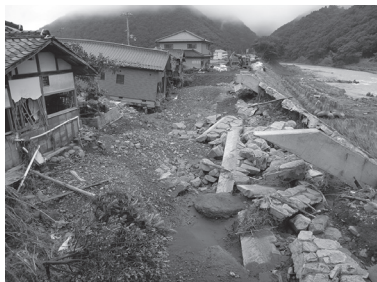
倒壊した佐用川の護岸
