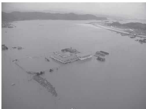
台風 23 号による水害で学校が孤立した出石町立小坂小学校(当時) 「台風 23 号災害検証報告書」より
