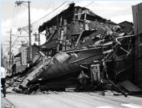
平成 28 年熊本地震で大きな被害を受けた益城町内の様子
