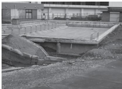
土砂に覆われ外壁が倒壊した丹波市立前山小学校のプール
