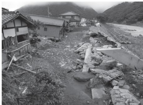
倒壊した佐用川の護岸
