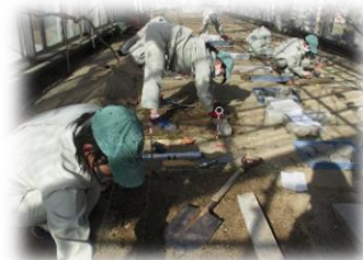
敷石と縁石の設置
