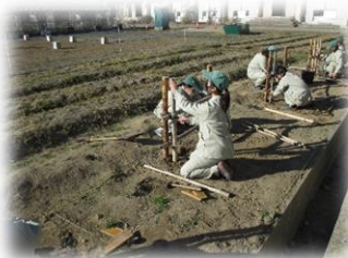
四つ目垣の設置
