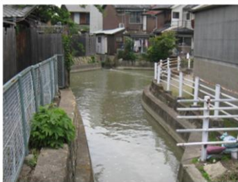
加古川城の内堀遺構水路
