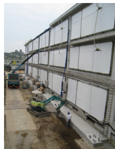
校舎は耐震工事中
