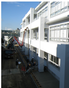
これがPCフレーム工法
