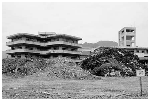
被災後、校庭が瓦礫置き場となった釜石東中学校
