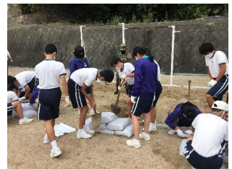
土のうづくり2
