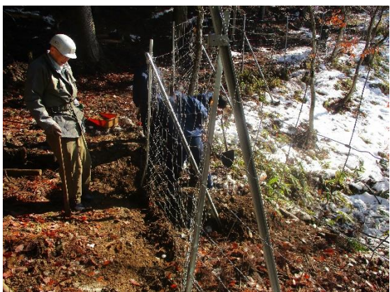
柵に溜まった土砂の除去作業です。
