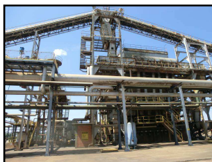
エタノール工場
