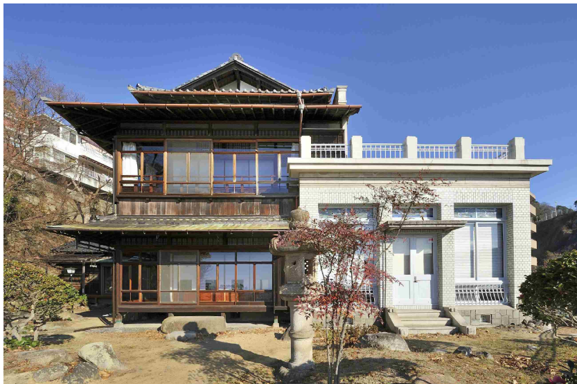
03旧坂家住宅 南面外観
