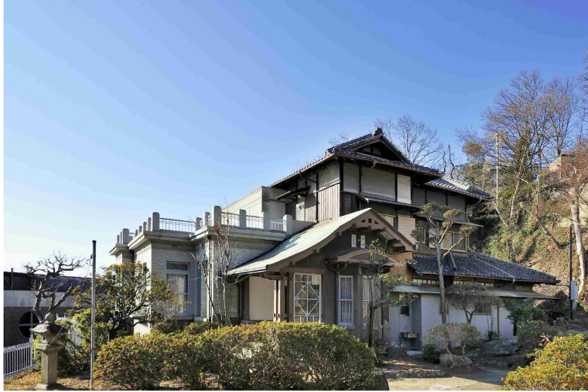
01旧坂家住宅 北東面外観
