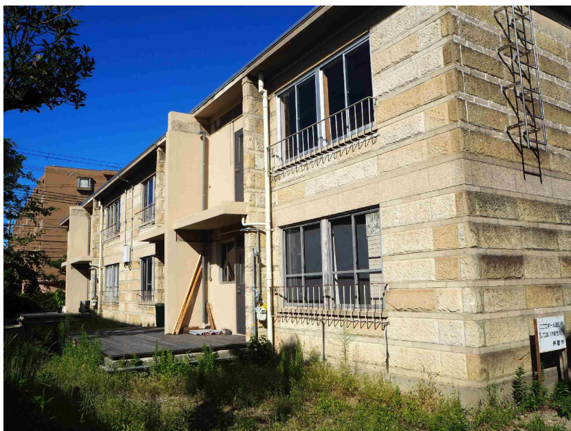
02旧宮塚町住宅 南東面外観
