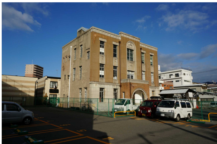
02 外観南東より見る
