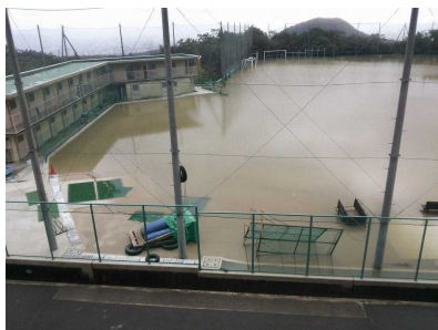
県立西宮甲山高等学校の校庭貯留(写真)
