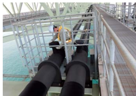
本州からの水道管
