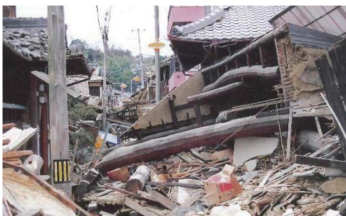
倒壊した建物
